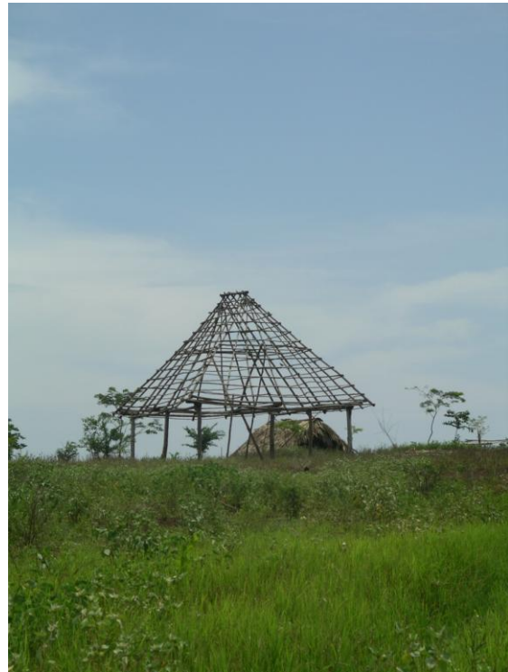
Vivienda en construcción
